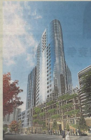
Yarra One 高级公寓的设施多元，有瑜伽室、舞蹈室、水疗和图书馆等。
