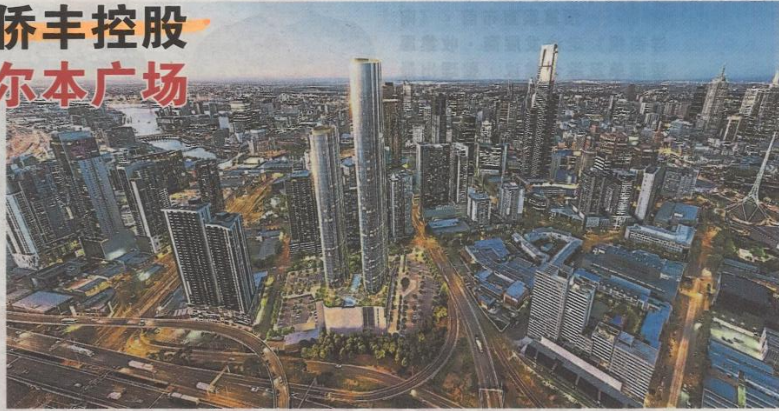
墨尔本广场首阶段包含两栋公寓、裙楼和公园，周围的停车场接下来将蜕变为公寓、办公楼和酒店。
